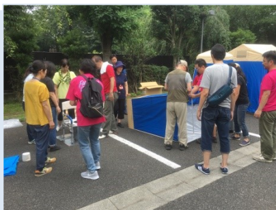
北門駐車場には仮設トイレ用の井戸とマンホールがあります。共同作業で仮設トイレを設置。
