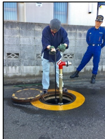
水道管へスタンドパイプとスピンドルドライバーをセットします。
