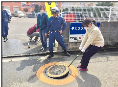
重い蓋もコツが解れば女性でも開けられます。後方に人がいないことを確認し、開けます。(ただし錆びている可能性もあります。)
