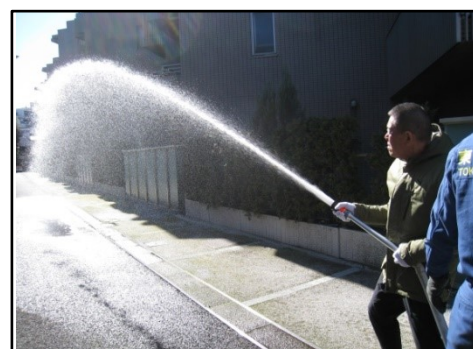
筒先をつけ「放水はじめ！」の合図でスピンドルドライバーを使い水道管を開き放水します。
