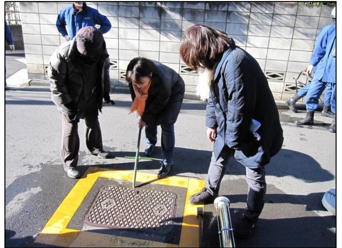
スタンドパイプ収納箱の中には消火栓を開けるための道具とスタンドパイプ、ホース、スピンドルドライバーが入っています。重い蓋もコツが解れば女性でも開けられます。（ただし錆びている可能性もあります。）
