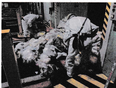
<搬入物検査の様子>
